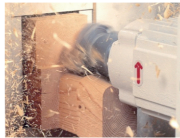
プレカット機械仕口加工
