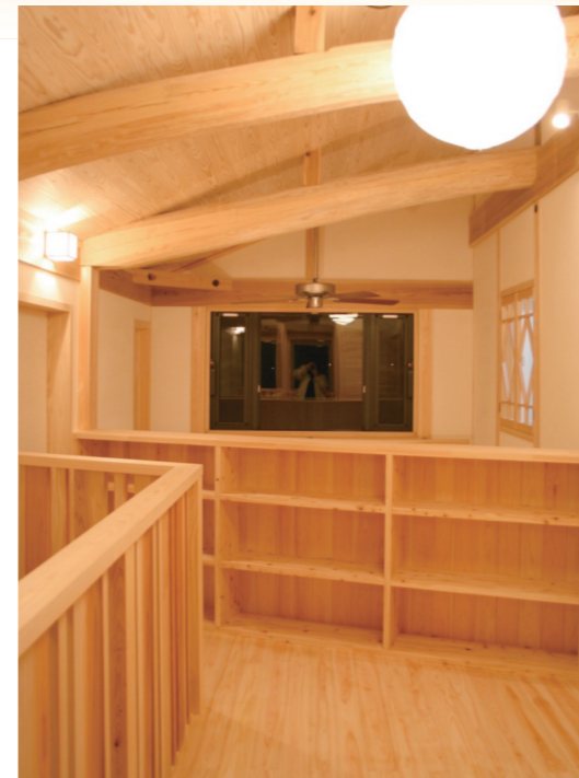
ヒノキフローリング、スギ板天井、地松化粧梁
