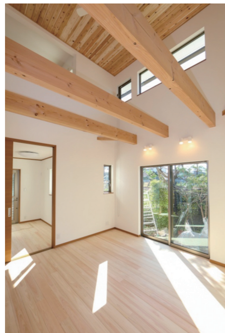
ヒノキフローリング、スギ板天井、地松梁
