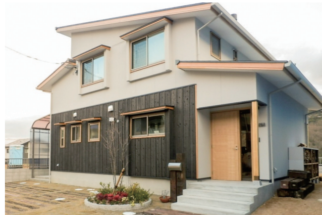
外壁に焼杉板を使用
