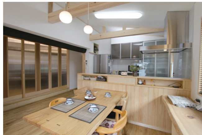
カウンター天板は天然杉、腰板にはヒノキを使用
